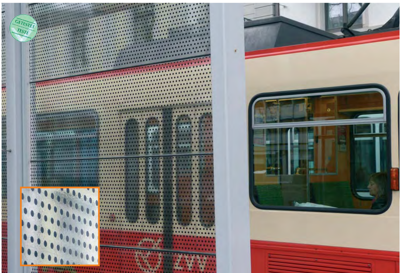
Cet arrêt de tram a été muni d'une trame de points. La visibilité au travers est assurée, le motif est discret.
