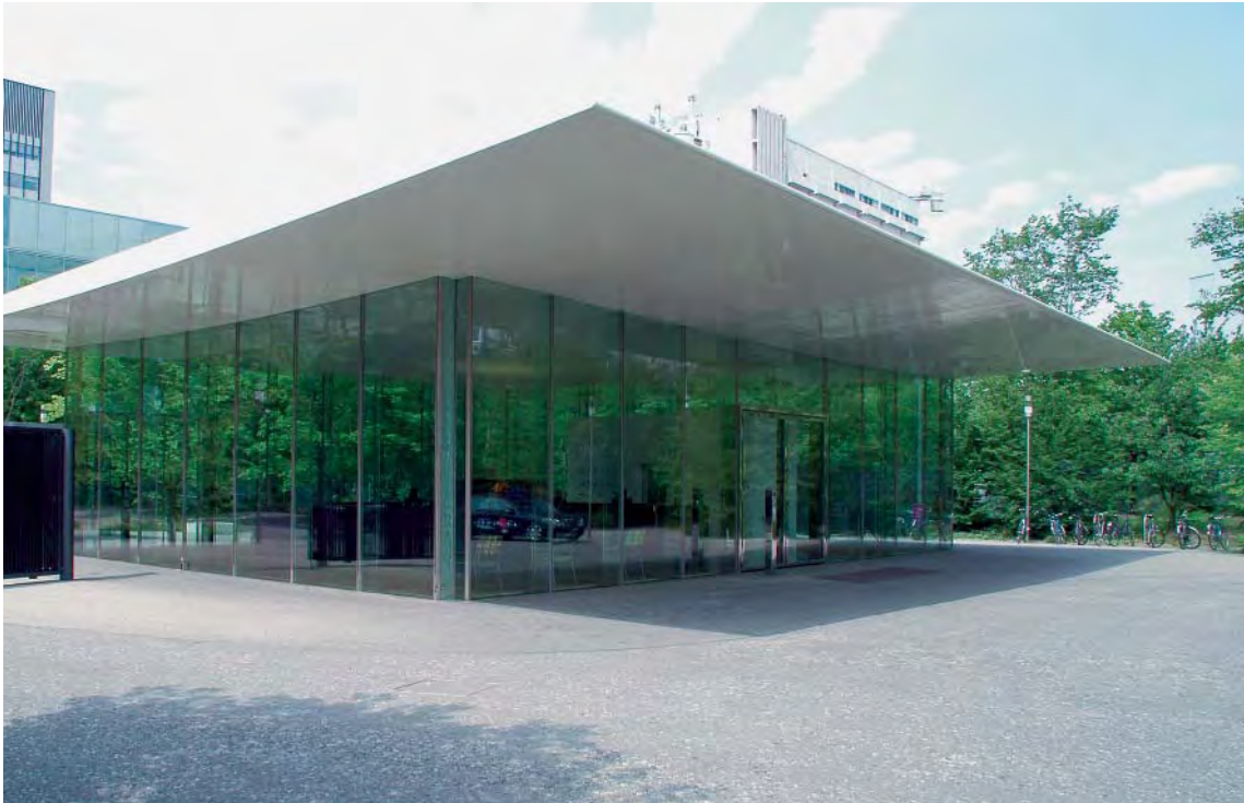
Bâtiment d'accueil d'une grande entreprise. Le lien optique entre la construction en verre et l'environnement est très dangereux pour les oiseaux. Les constructions au bord de l'eau ou dans les parcs sont également très problématiques quand les façades réfléchissantes rendent difficile la distinction entre environnement et bâtiment.
