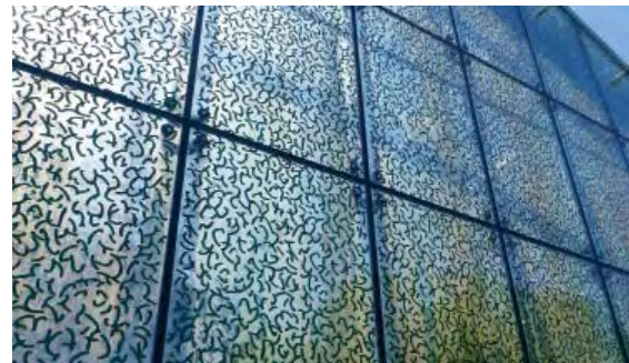
Ce décor de la serre tropicale du zoo de Schönbrunn prévient également les collisions des oiseaux exotiques se trouvant à l'intérieur.
