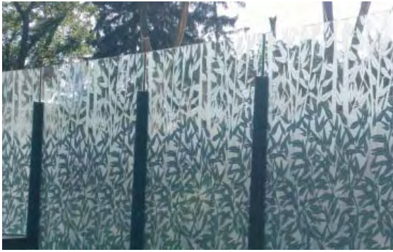
Paroi antibruit: efficace malgré le motif végétal.
