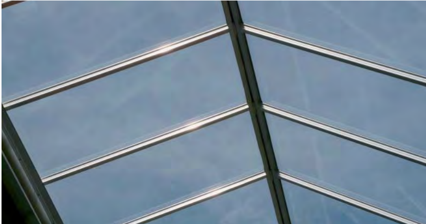
Les toitures en verre à deux pans ne représentent aucun danger pour les oiseaux.
