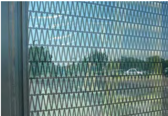
Cette sérigraphie a été appliquée à l'intérieur du verre isolant. Les réflexions restent donc malheureusement visibles.
