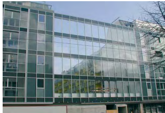
Paroi antibruit et coupe-vent entre deux bâtiments
