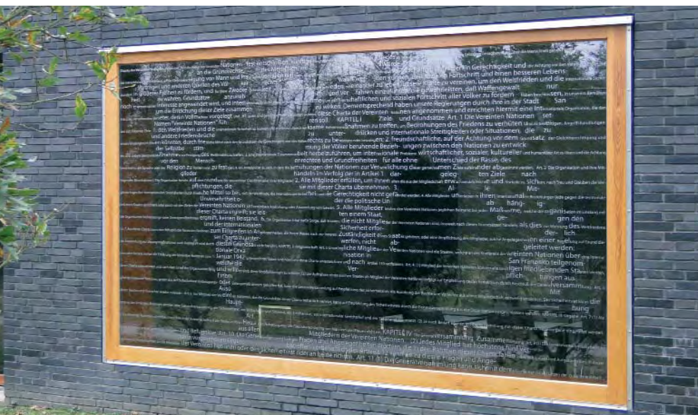
Marquage innovateur d'une vitre réfléchissante sur l'office des affaires étrangères à Berlin-Tegel.
