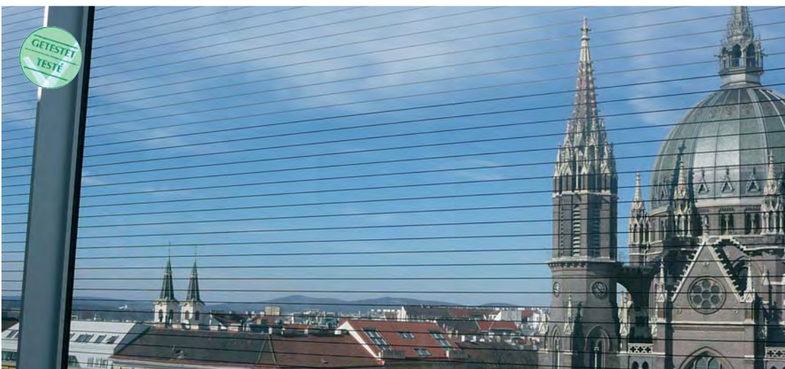
Des lignes noires horizontales d'une épaisseur de 2 mm avec un espace de 28 mm ont obtenu, contre toute attente, de bons résultats dans le tunnel de vol. Lorsque la visibilité doit rester maximale, cela pourrait être un compromis acceptable devant un arrière-fond clair. Nous recommandons toutefois de faire des lignes d'une épaisseur minimale de 3 mm.
